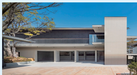
トイレの文化館 提供:INAXライブミュージアム
