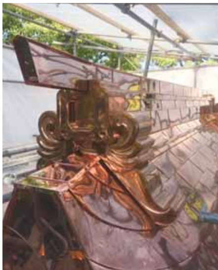
銅板屋根工事
